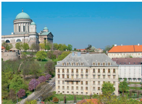
5. kép: Az épület ma (saját fotó)
